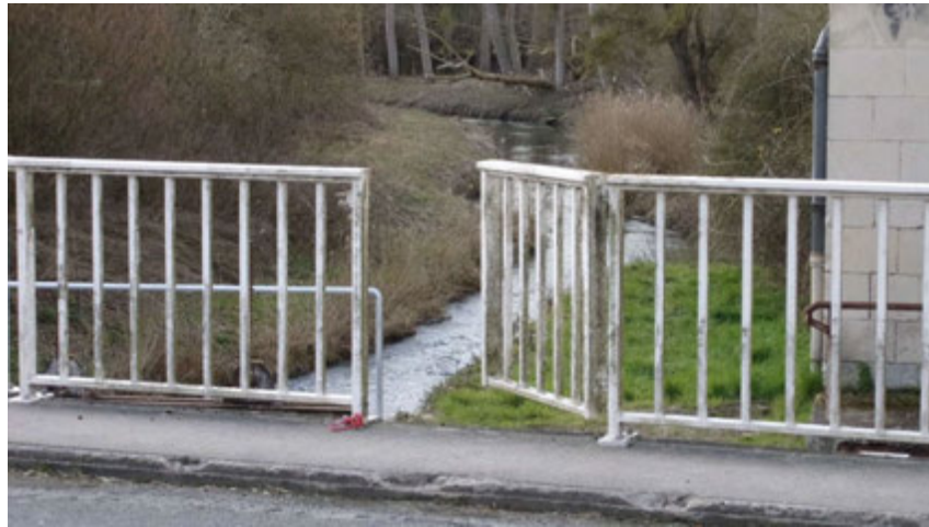
Guichet d'aspiration sur un pont, réserve naturelle
