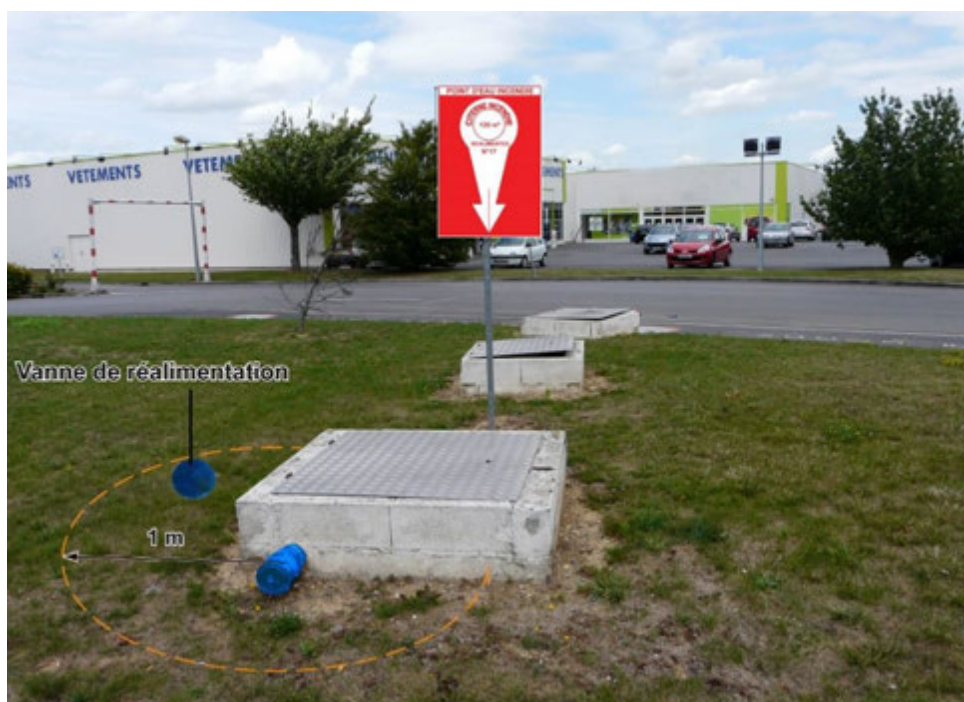
Exemple d'une vanne de réalimentation présente dans le rayon de 1 mètre Le panneau de signalisation ne mentionne pas sa position
