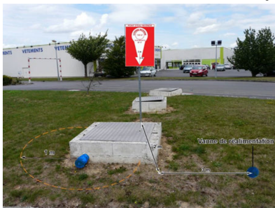
Exemple d'une vanne de réalimentation présente hors du rayon de 1 mètre Le panneau de signalisation mentionne sa position
