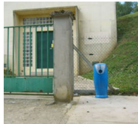
Exemple d'une prise château d'eau avec un poteau d'aspiration
