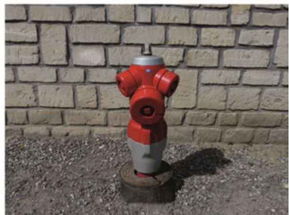
Poteaux incendie de 100 mm
