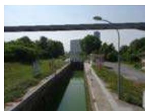
Écluse du Canal de l'Aisne à la Marne
