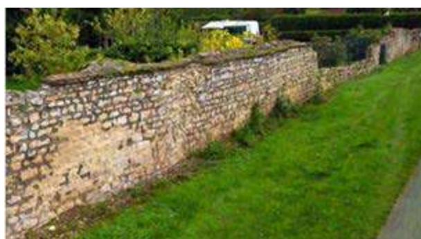
Mur ancien situé rue d'Origny
